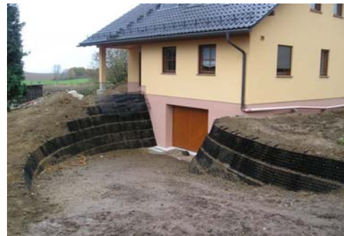
Fertiggestellte, noch nicht begrünte Steilböschung des Pilotprojektes in Struppen bei Königstein
