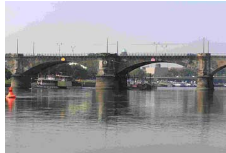
Ansicht der Brücke von der Oberstromseite
