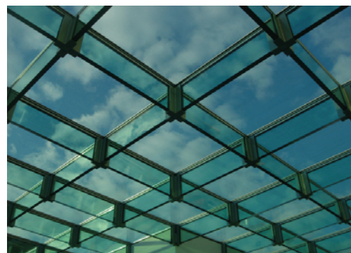
Glasdach mit gläserner Tragstruktur
