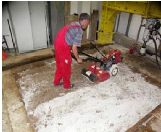
Vorbereitung des Großversuches - Herstellung einer Bodenverbesserung
