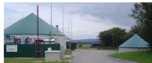
Biogasanlage der LAWI Agrar GmbH Hirschfeld (Landkreis Zwickau)
