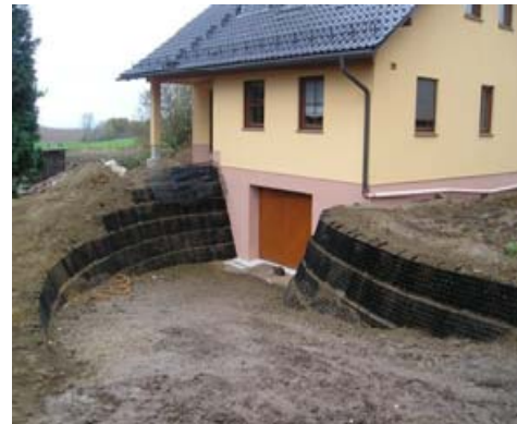
Fertiggestellte, noch nicht begrünzte Steilböschung des Pilotprojektes in Struppen bei Königstein
