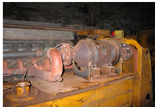
Partikelfiltersystem mit Partikel-sensoren an einem Fahrlader für den Untertage-Einsatz
