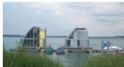
Die ersten beiden bereits errichteten Modulhäuser der Wohnsiedlung Scado am Geierswalder See auf Stahlpontons mit Glasflake-Korrosionsschutz
