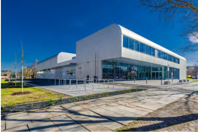
Abb. 4: Neu errichtetes Technikum für Fahrzeugtechnik der HTW Dresden
