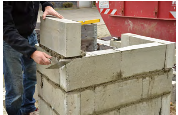
Herstellung einer Probewand mit CFLC-Mauersteinen
