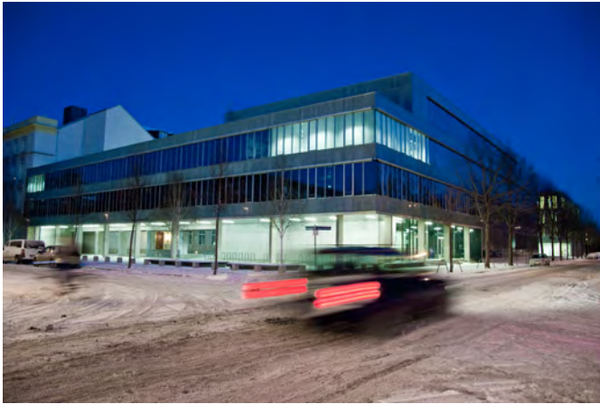
Das Laborgebäude für Ingenieur- und Naturwissenschaften der HTW Dresden wurde nach Kriterien für nachhaltiges Bauen analysiert und bewertet
