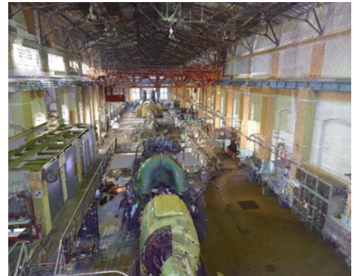
Visualisierung der Halle des Kraftwerks Hirschfelde aus einer kolorierten 3D-Punktwolke
