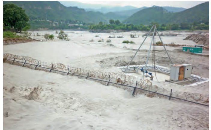
Bild 3. Sedimentablagerung am Uferfiltrations-Brunnen in Srinagar nach dem Hochwasser, Juli 2013. © C. Sandhu / HTW Dresden
