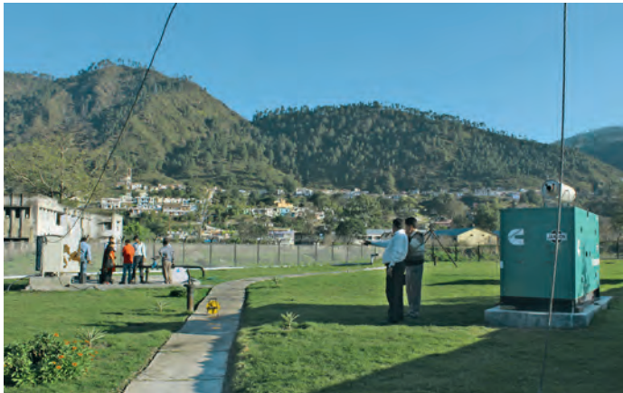
Bild 2. Uferfiltrations-Brunnen in Srinagar vor dem Hochwasser im März 2013. © T. Voltz / HTW Dresden
