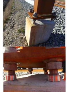
Abb.: Abstandsmontage in Dänemark
