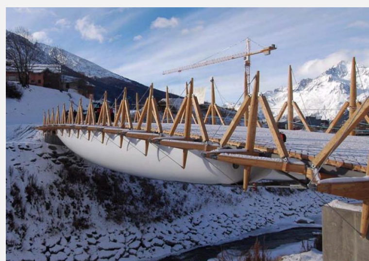
Skibrücke in Lanslevillard in Tensairity-Bauweise
