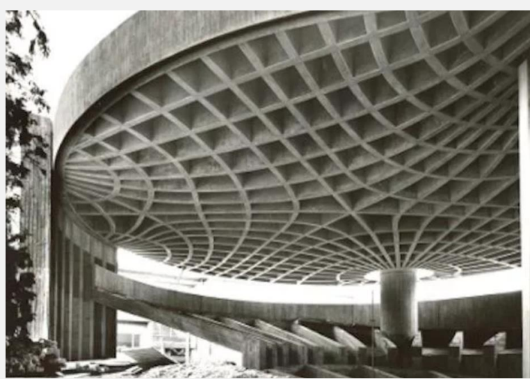
Deckenstruktur des Zoologie Hörsaals der Uni Freiburg
