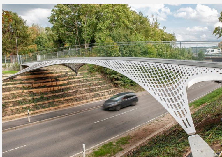
TRUMPF-Steg in Ditzingen als Schalenkonstruktion
