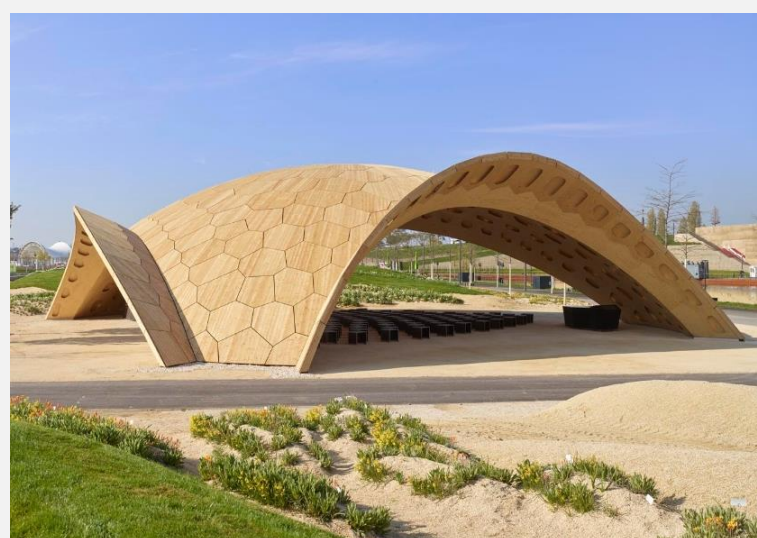
Segmentierter Holzpavillon zur BUGA 2019 in Heilbronn
