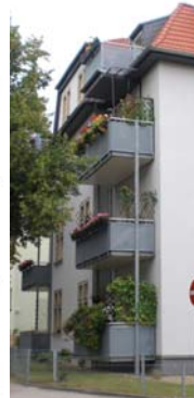
Mittig gestützter Balkonturm mit verzinkter Stahltragkonstruktion und Holzbohlenbelag
