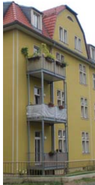
Verzinkte Stahlkonstruktion, Holzbohlenbelag, Trapezblech als wasserführende Ebene
