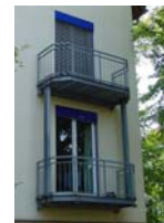
Vorgehängte zweigeschossige Balkonanlage statisches System: Zwei-Gelenk-Rahmen
