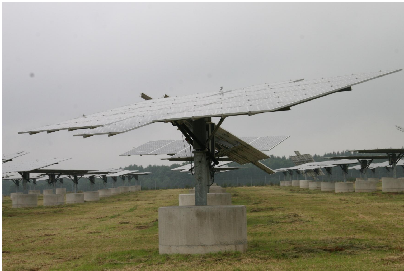
Abbildung 1: Beispiel für die Gründung von Solarkraftwerken (Nähe Freiberg)
