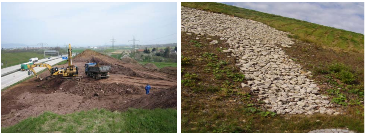
Abbildung 8: Sanierung von Rutschungen, links: kompletter Neuaufbau, rechts: Grobschlag
