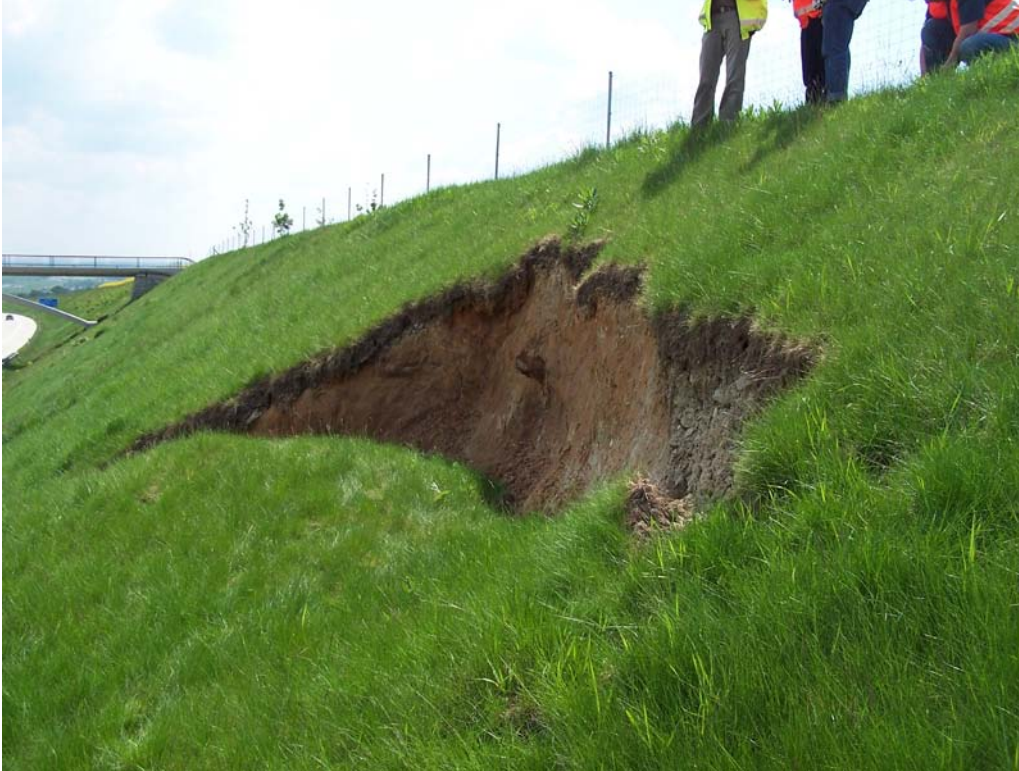
Abbildung 1: Böschungsruftung an der BAB A17
