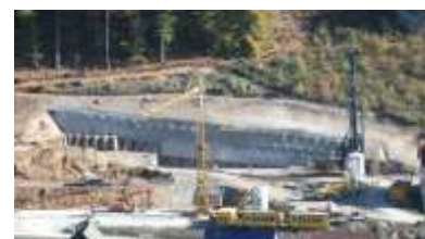
Hotel-Sponsel-Regus, Heiligenstadt, Baugrubensicherung
