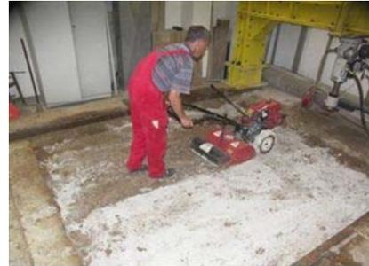
Vorbereitung des Großversuches – Herstellung einer Bodenverbesserung
