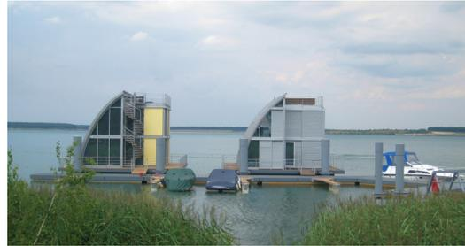
Die ersten beiden bereits errichteten Modulhäuser der Wohnsiedlung Scado am Geierswalder See auf Stahlpontons mit Glasflake-Korrosionsschutz
