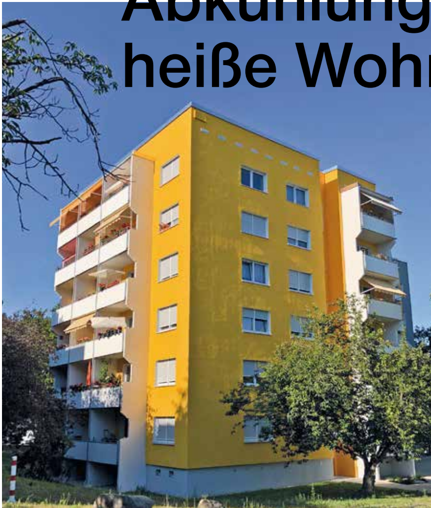
Außenliegende Jalousien und Rollläden sorgen in den frisch sanierten Gebäuden auf der Höhenpromenade im Dresdner Stadtteil Gorbitz dafür, dass die Wohnungen sich in Hitzeperioden nicht mehr so stark aufheizen.
