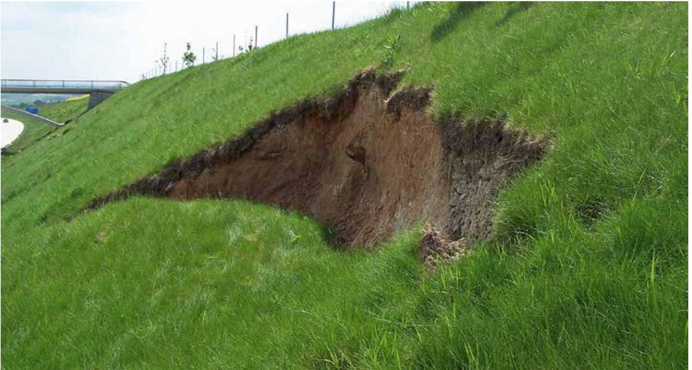
Abb. 1: Böschungsrutschung an der BAB A17
