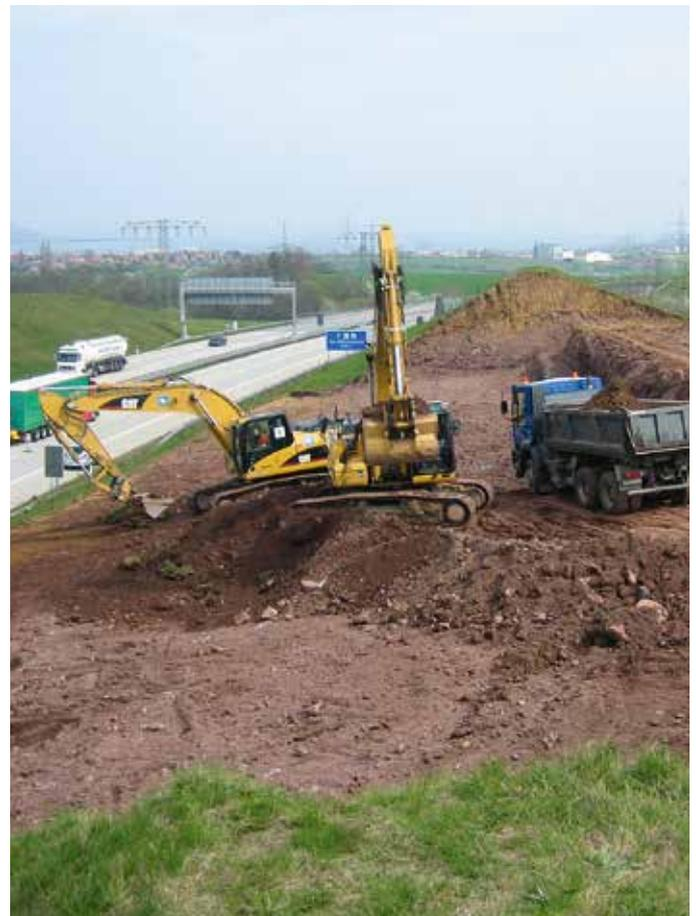
Abb. 3: Sanierung von Rutschungen
