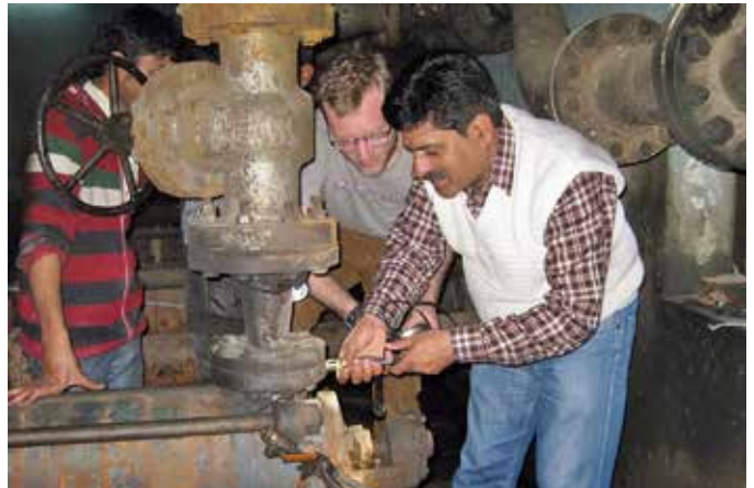
Tom Voltz (HTW Dresden) und Ingenieur Saini (UJS) bei der Installation eines Manometers für Messungen der Energieeffizienz einer mehrstufigen Kreiselpumpe in Srinagar.
