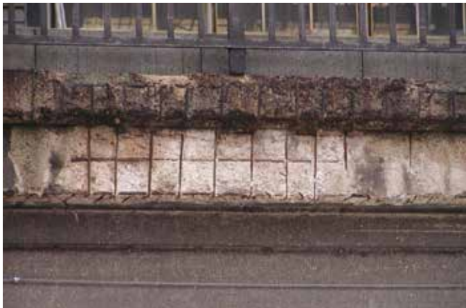
Abb. 1: Betonabplatzung durch korrodierte Bewehrung an einer Brückenkappe
